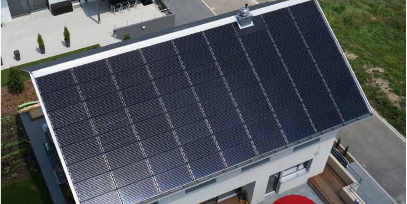
Die Indachlösung – PV-Generator und Dacheindeckung in einem
