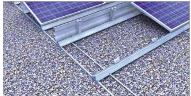
Kiesschüttung: Süd-System I mit Kreuzverbund
